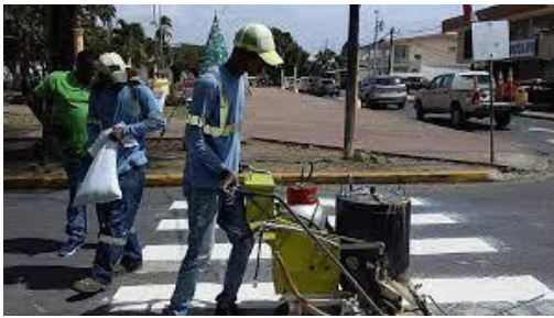
Ilustración 4: Mantenimiento paso peatonal. Fuente: CoopRed (2017)
