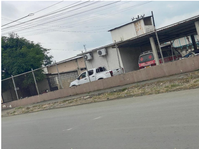
Hospital Básico del Cantón Balzar sin señalética.
