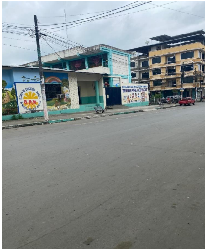
Escuela Benigna Pareja no existe señalización de zona escolar
