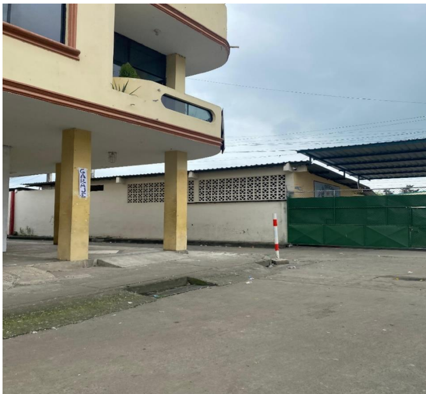
Calle olmedo no existe señalización del pare.
