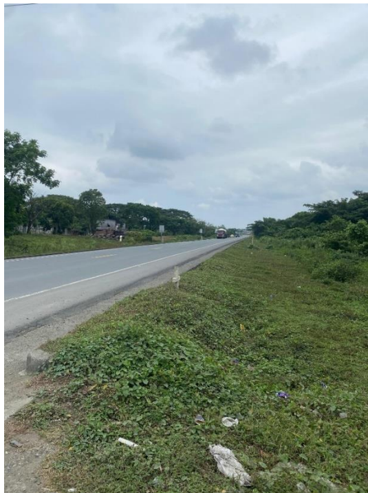
Vía perimetral sin tener zona de radares de velocidad.
